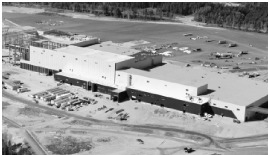
Le système Murox® a connu une bonne année avec la réalisation de 103 projets comparativement à 81 en 2000. L'usine Timberstrand LSL à Kenora en Ontario, a été construite avec le système Murox®.
