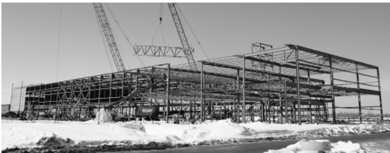
Les activités principales du Groupe dans le secteur des poutrelles d'acier et des autres composantes métalliques sont liées directement à l'industrie de la construction non résidentielle. Ci-dessus, une partie de l'usine Bombardier à Mirabel au Québec, un projet qui a requis plus de 6 500 tonnes d'acier.
