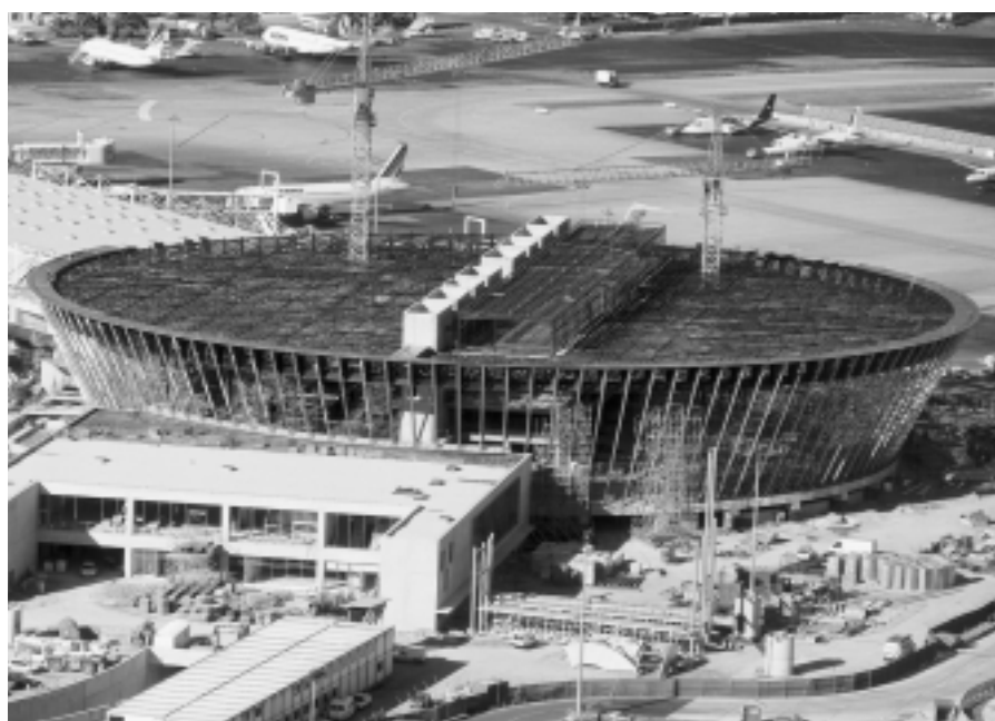
Les ventes totales des filiales et divisions Canam ont atteint 827 748 000 $ en 2001. Ci-dessus, le Terminal 2 de l'Aéroport Nice Côte d'Azur fait partie des projets réalisés par Canam France en 2001.
