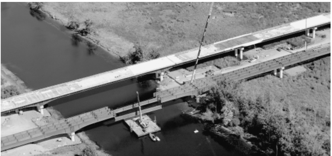
Le pont de la rivière Mississippi, situé à Antrim en Ontario, a été fabriqué à l'usine de Canam Structural à Québec. Ce projet a totalisé 1 715 tonnes d'acier.
