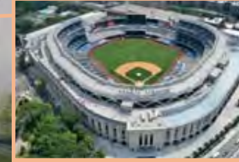
USINE 10 (2008) Charpente métallique et pièces de pont Le nouveau Yankee Stadium a été complété en 2008 et a une capacité de 51 800 spectateurs.
