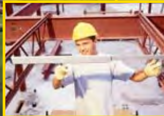
USINE 2 (1972) Poutrelles Hambro, courte portée et moyenne portée Au chantier, un ouvrier installe une barre d'appui entre deux poutrelles Hambro
