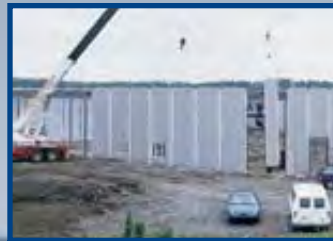
USINE 7 (1990) Système de murs préfabriqués Murox Installation au chantier de panneaux de murs préfabriqués Murox.
