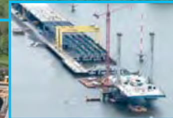
USINE 12 (2010) Charpente métallique et pièces de pont Le pont de l'autoroute 25 reliant Laval à Montréal au dessus de la rivière des Prairies comporte six voies de circulation et mesure 1,2 kilomètre de long.
